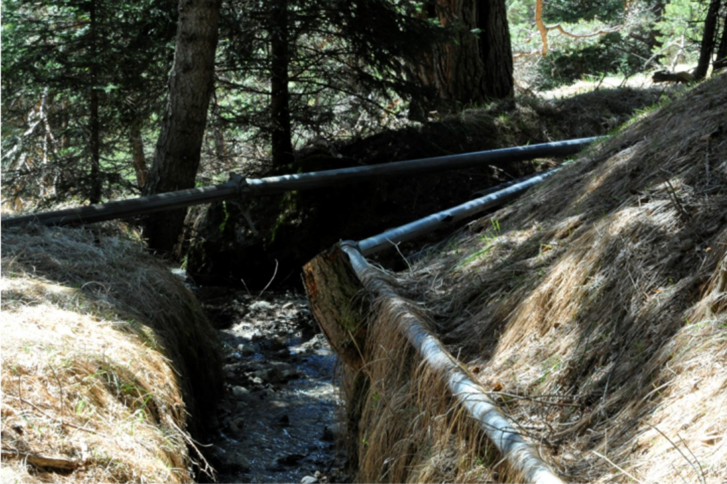
Ramosch, fliegende Röhren in alten Bewässerungsgräben
